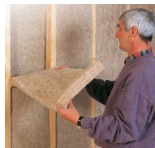
Mise en oeuvre
