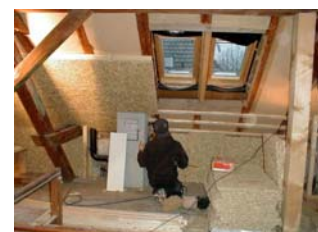
Mise en oeuvre
