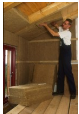
Mise en oeuvre
